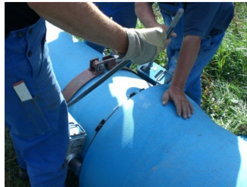
Bild 2 – Verriegeln mit Hydraulikzylinder
