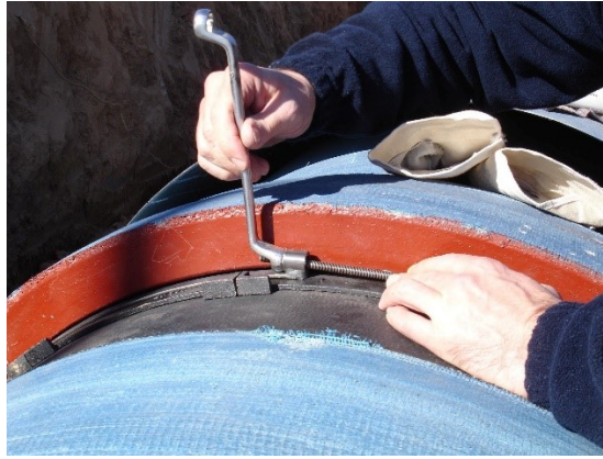
Bild 3 – Fixierung der Verriegelungssegmente mit verschraubter Spannschelle
